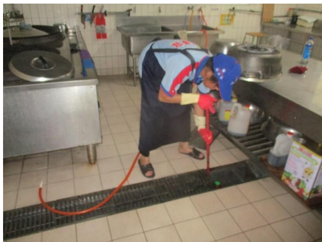
廚工每週一次定期清潔廚房內的排水溝
